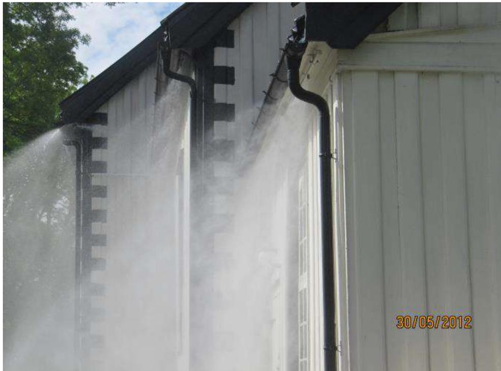
Fig. 3.5.2 Sistema per la protezione delle facciate (facade system)
