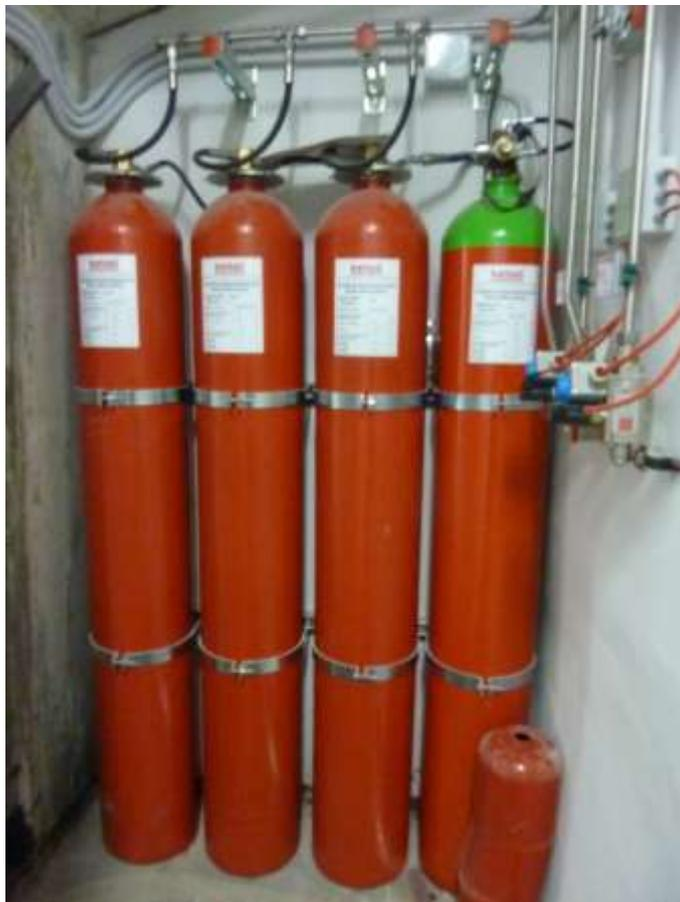
Fig. 3.5.2: tipico gruppo di pressurizzazione per sistema con saune
